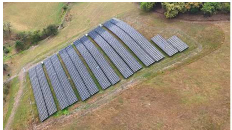
Foto: CCE Österreichs erste Agri-Photovoltaikanlage mit Schafhaltung in Grimmenstein Niederösterreich mit einer maximalen Nennleistung von 905 kWp
