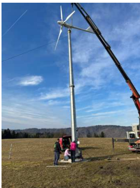
Fotos von der Errichtung einer Kleinwind-Anlage © Kleinwind GmbH
