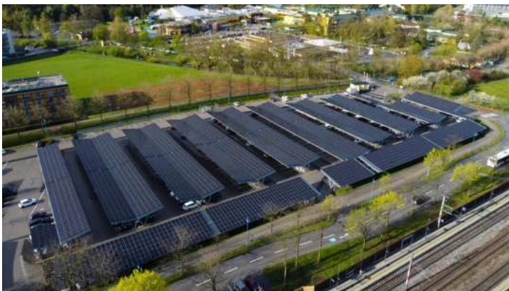
Foto: Carport-Photovoltaikanlage für die Eurotherme in Bad Schallerbach mit einer maximalen Nennleistung von 1,2 MWp
